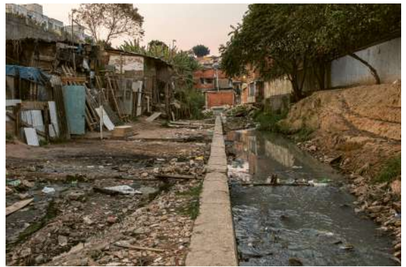
Esgoto a céu aberto em comunidade
