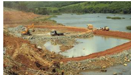
Construção da Usina São Roque, em Santa Catarina
