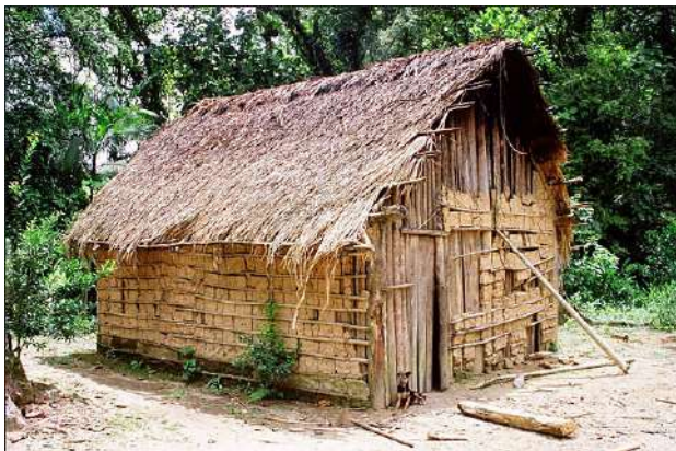
CASA TRADICIONAL GUARANI COBERTURA VEGETAL TEKOÁ PEGUAOTY
