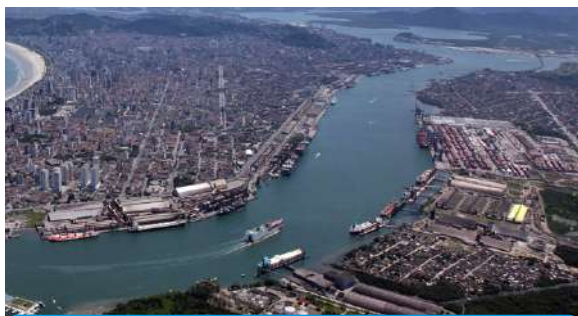
Vista aérea do canal do Porto de Santos
